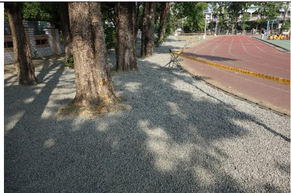
說明：鋪設好的地面整齊美觀
