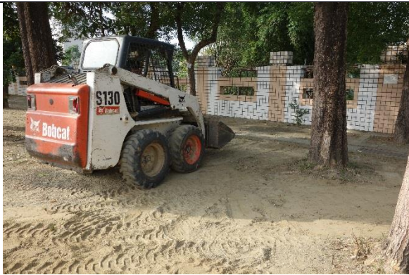
說明：利用山貓鋪裝前先整地
